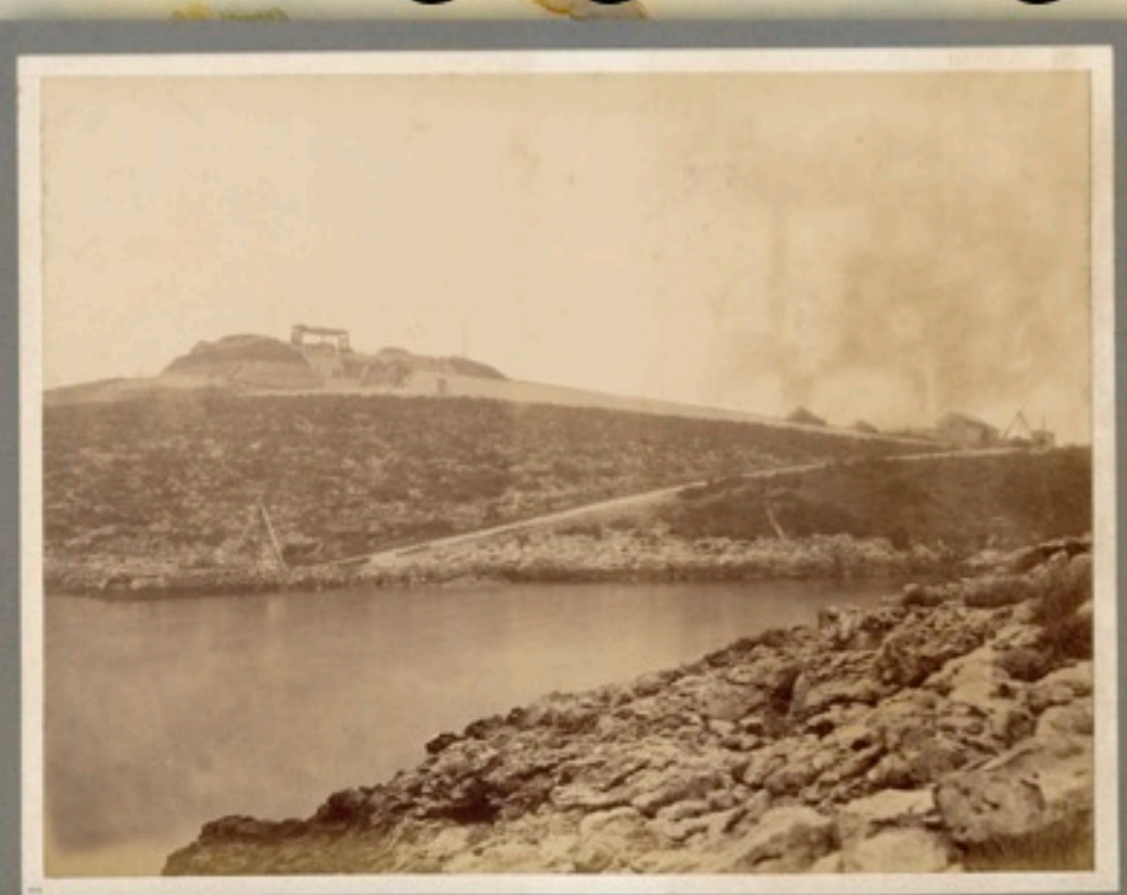
PPMI-F-1134 Izgradnja utvrde Verudela, oko 1885.g.
